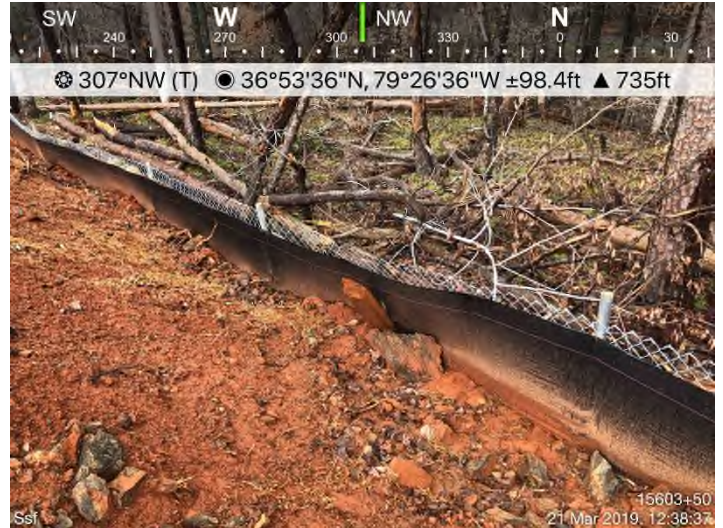
Fig. 4: STA 15603+50 - Repair SSF.
