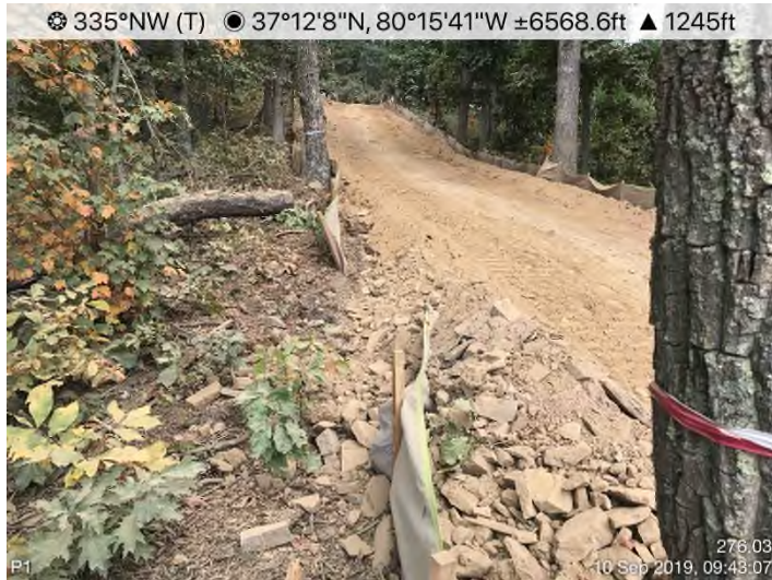
Fig. 3: STA 12360+91 – Stabilize fill slopes.
